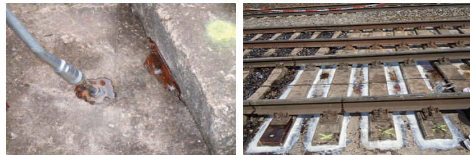
開けた穴に射出用樹脂 GREBOPOX® を注入することで、枕木は再び固定されます。
