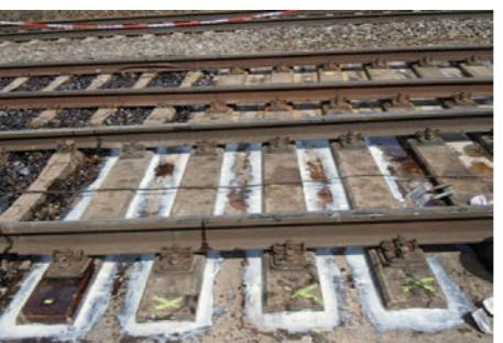
*La résine GREBOPOX® SVH est injectée dans le trou réalisé, ce qui permet ainsi de stabiliser la traverse.*
